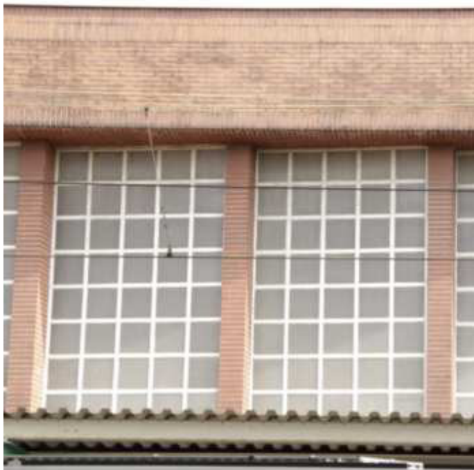
Sklobetonové výplně ve 2.NP určené k obnově (okno 107) – pohled z interiéru a exteriéru
