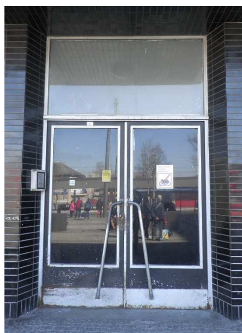
Severní fasáda – výstřižek z původní dokumentace (SHP str. 232) – vzor pro dělení vstupních dveří 101
