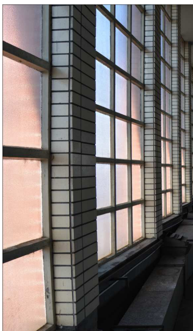
Sklobetonové výplně ve 2.NP určené k obnově (okno 107) – pohled z interiéru a exteriéru
