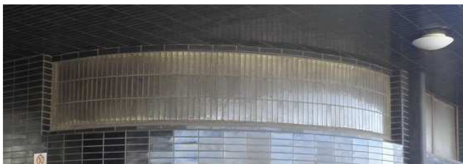
Severní fasáda – stávající sklobeton – vyčištění a nové vyspárování (okno 102)
