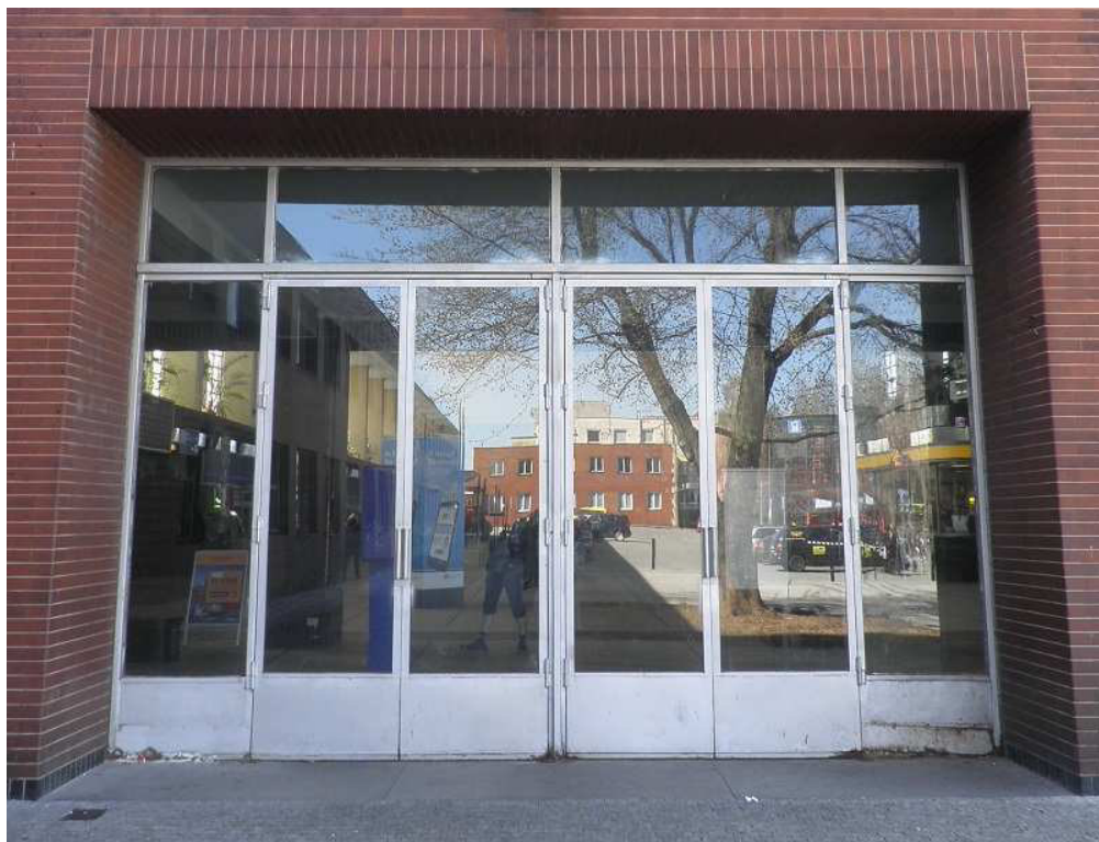
Východní fasáda – stávající sestava dveří se světlíky – vzor pro repliku (dveře 105)
